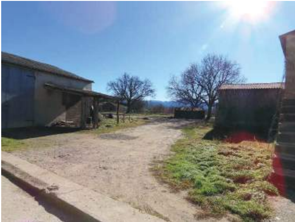
Imagen 38: Otro ejemplo de la necesidad de separar la calle/calzada de las instalaciones agrícolas de hormigón y tejados de uralita.
