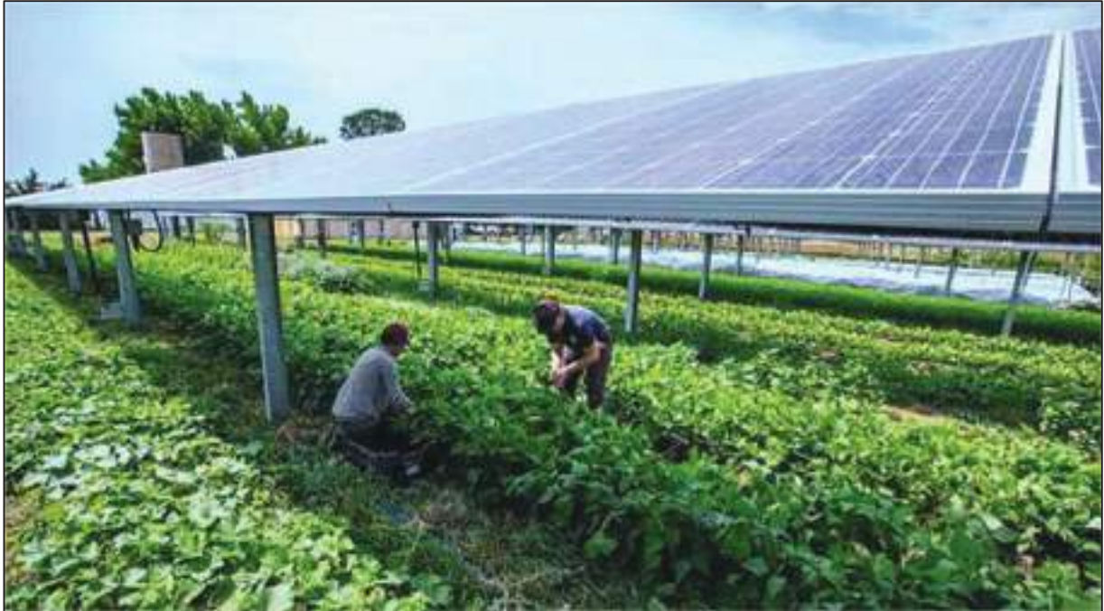
Ilustración 5. Aprovechamiento de cultivos de hortalizas bajo paneles solares.
