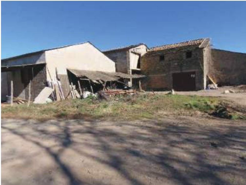
Imagen 42: En distintos puntos del pueblo existe basura y residuos que deberían ser limpiados, tanto para no dar una sensación de abandono y dejadez como por suponer un peligro para los niños, o incluso un foco de incendios.
