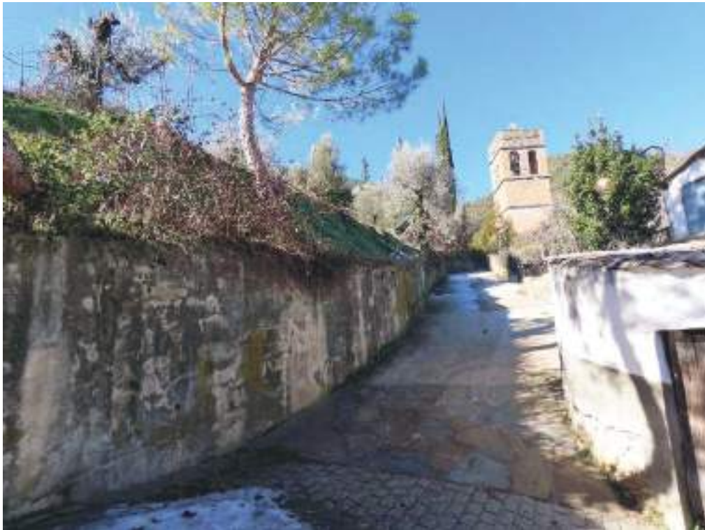
Imagen 16: De nuevo, con el fin de embellecer visualmente las calles, sería interesante cubrir algunos muros con especies trepadoras que permitan ocultar al máximo los muros de hormigón.
