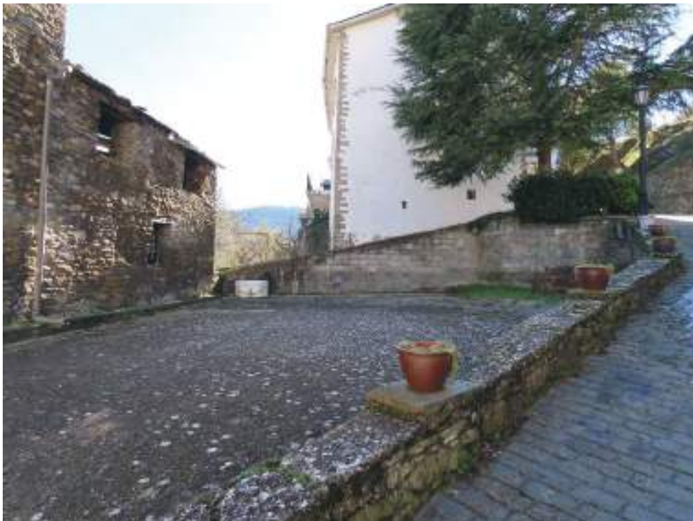
Imagen 15: Otro ejemplo sobre mejorar visualmente los muros no tan estéticos de la localidad, en este caso la pared de bloques del fondo en esta pequeña plaza (Calle de la Iglesia). En el muro en primer término se podría incrementar los maceteros y pensar medidas para garantizar su automantenimiento.
