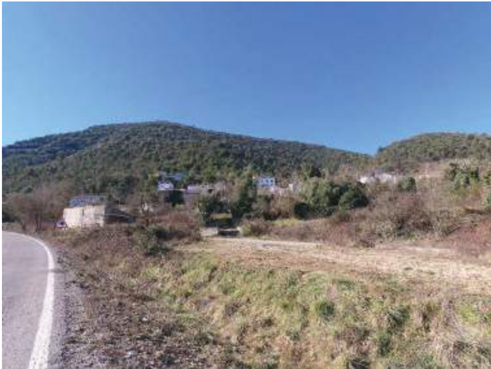
Imagen 20: Este es el caso de la carretera que da acceso al pueblo y que continúa hacia el centro del valle. Se hace urgente la limpieza de la vegetación de las cunetas por el alto riesgo de incendio que pueden suponer dejarlas en este estado.
