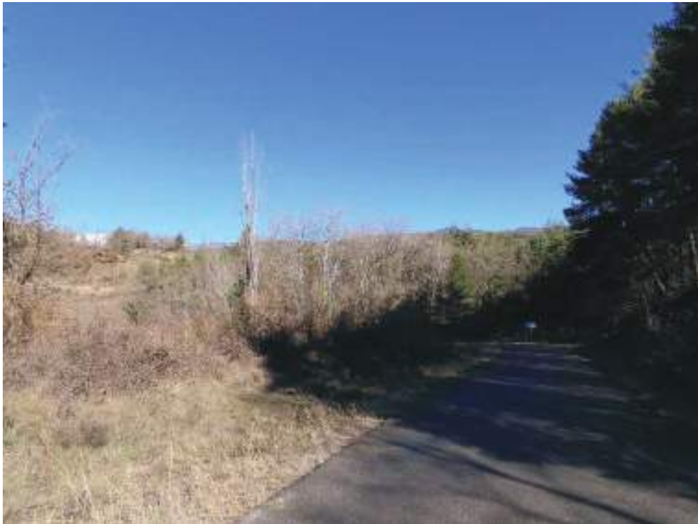
Imagen 28: En la entrada a esa localidad, existe vegetación en las cunetas que debería ser limpiada y desbrozada para evitar que los posibles incendios forestales accedan al núcleo.
