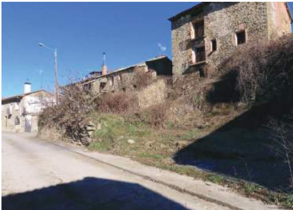
Imagen 27: Existe alguna parcela en estado de abandono, como la de este ejemplo en la Calle Única, que necesita con urgencia una limpieza de vegetación pues puede convertirse en el foco de un posible incendio. En este caso se debería retirar toda la vegetación arbustiva en los bordes de la parcela y recortar las herbáceas del suelo, evitando así un posible fuego por alguna colilla, alguna chispa derivada de maquinaria agrícola que circula por esa calle, etc. Se podrá plantear una vegetación ajardinada alternativa que mantenga la parcela verde pero sin tanto riesgo frente a incendios y mostrando esa sensación de abandono.
